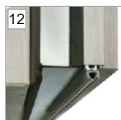
Czwarta przyłga i uszczelką samoopadającą (brak możliwości skrętu)
