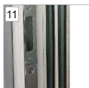
Przegroda termiczna, dwie uszczelki w ościeżnicy
